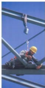
Esempio di sistema anticaduta con uso di imbracatura - fune di sospensione avvolgitore - ancoraggio
