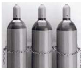
Figura 3: Catene per proteggere le bombole di gas contro capovolgimenti.
